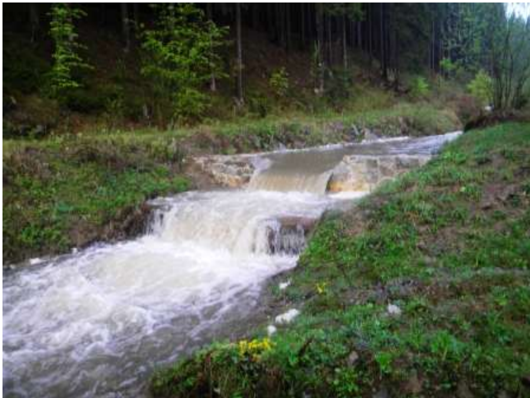
Obr.č. 10 Pohľad na úpravu vodného toku (stupňe)
